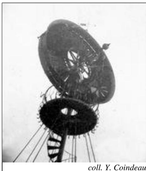
*L'éolienne de Mesnes, installée en 1884, était une éolienne Bollée, constructeur au Mans, de type colonne haubanée modèle n°3. Son rotor de 5 m de diamètre à 32 pales permettait une capacité d'élévation de l'eau de 3,6 m<sup>3</sup>/h. Située au milieu du chantier d'implantation de l'actuel Centre Médico-Social des Brunetières, l'installation fut démontée à la fin des années 1960.*
